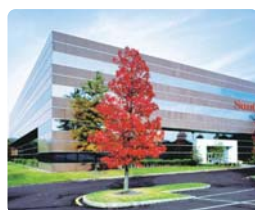
Sun Chemical Corporation 本社 (米国)
