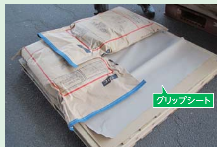
養生材としてグリップシート使用
