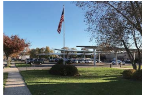
カールスタットのR&Dセンターに設置した太陽光パネル
