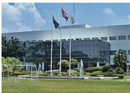
太陽光発電設備を導入した工場
