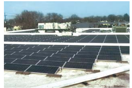
サンケミカル社カールスタット研究所に設置された太陽光パネル
