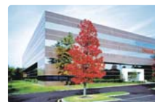
Sun Chemical Corporation 本社 (米国)
