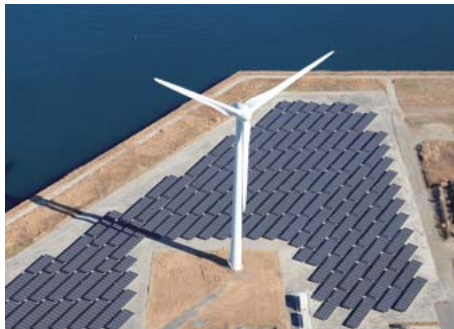
鹿島工場のメガソーラーと風力発電設備
