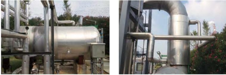
排熱の有効利用のため新設した温水タンク(左)と熱交換器(右)
