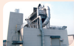
揮発性有機化合物の処理装置（埼玉工場）
