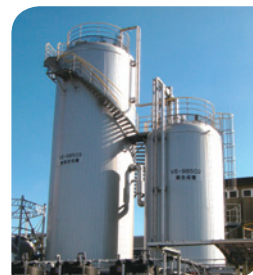
鹿島工場の嫌気性排水処理装置「バイオインパクト」
