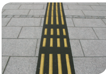
点字誘導ブロック
