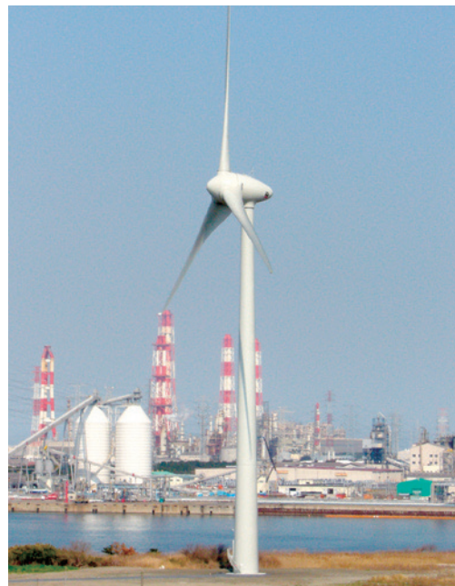
風力発電設備(運河の手前部分がDIC鹿島工場の敷地です)
