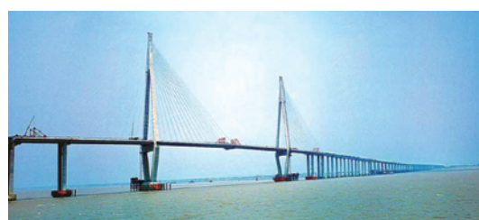
DICの機能性樹脂を用いた橋りょうへの塗装例
