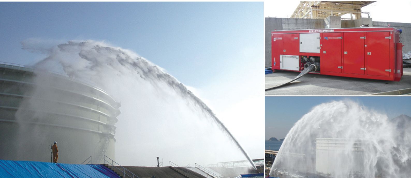
(左、右下写真)大容量実泡放水テスト場面、(右上写真)水中ポンプ一体型大容量送水ポンプ
