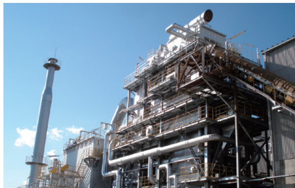
バイオマス発電設備の外観
