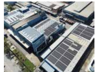
在马来西亚安装的太阳能电池板
